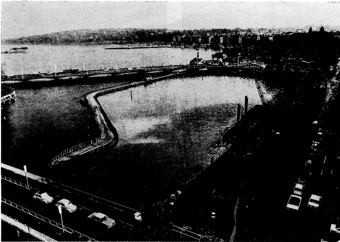
Fig. 6 Vue du batardeau avant le pompage de la surface de travail.
