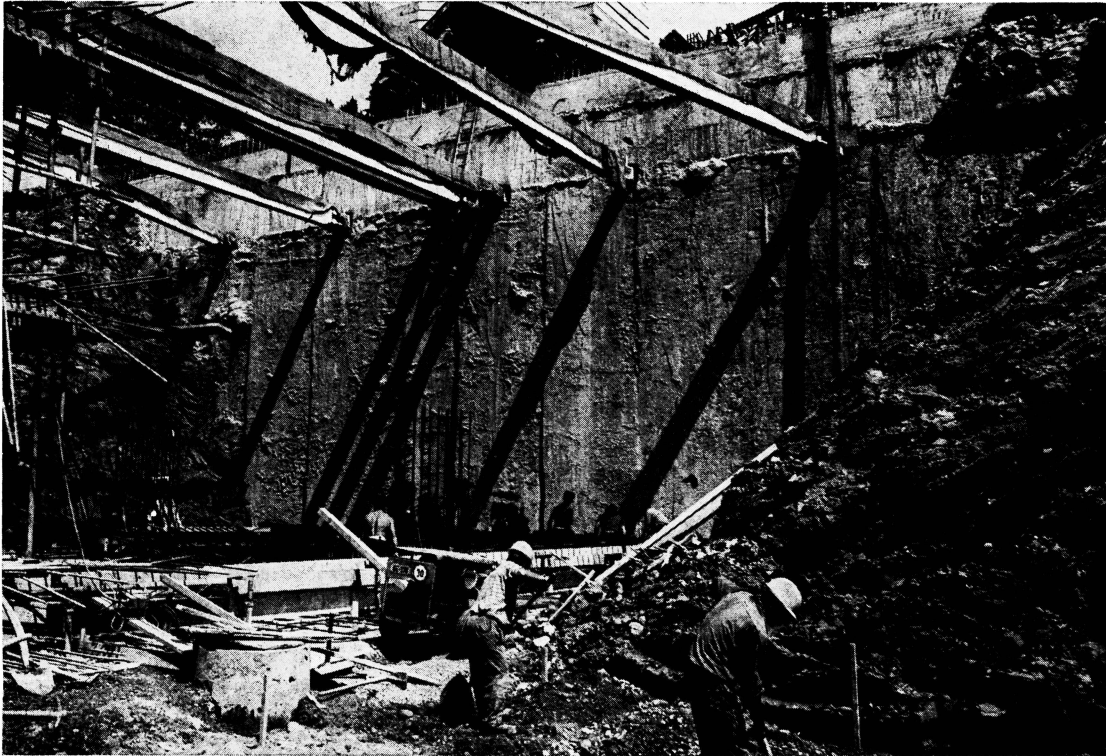
Fig. 9 Etagage supérieur de la paroi moulée dans le sol lors de l'exécution de la 1 re tranche.
